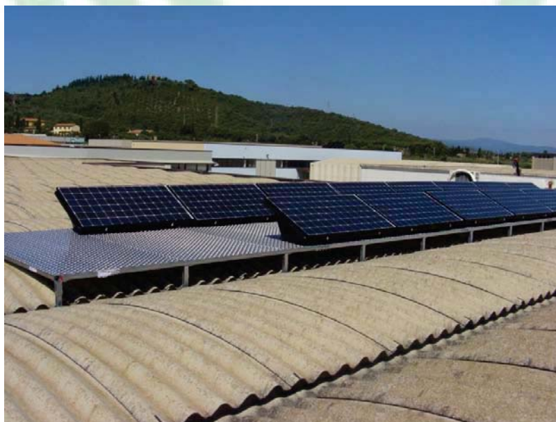
Figura 16 - Esempio di installazione non idonea alla classificazione dell'impianto fotovoltaico nella categoria "su edifici" – Motivazione: i moduli fotovoltaici non sono appoggiati alla superficie di copertura.
